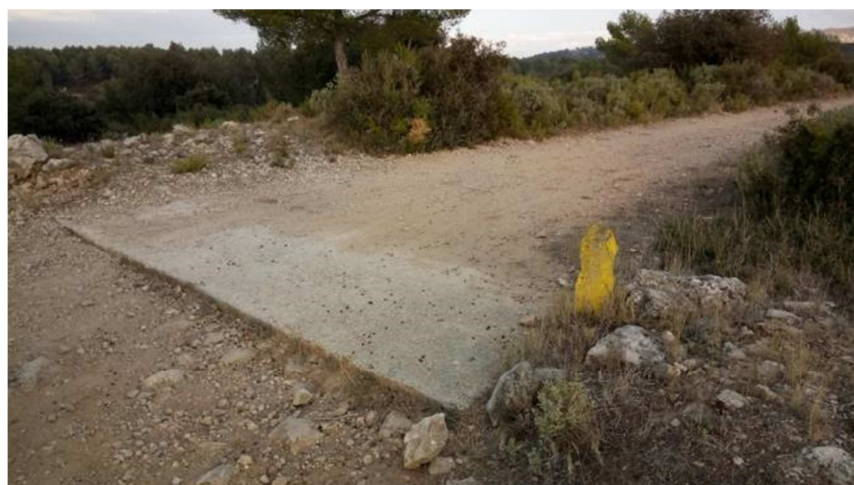
Photo 3 : Portion commune aux tracés 1 et 2, canalisation souterraine de gaz traversant la piste (Photo : INDDIGO, 2017)
