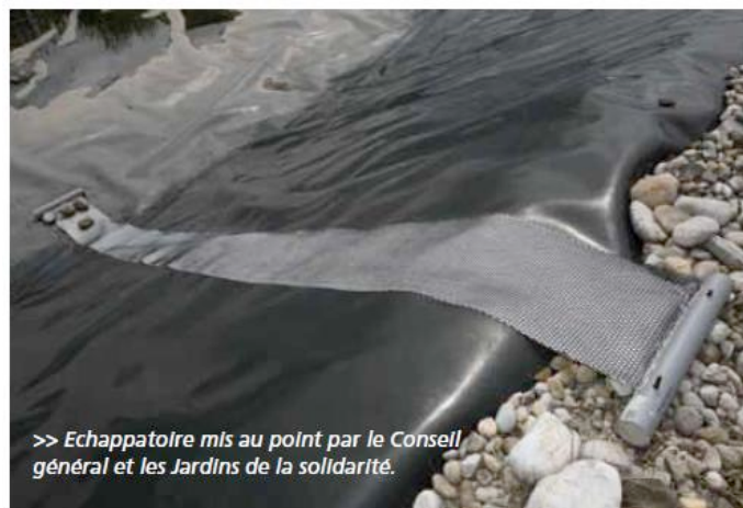
Exemple d'échappatoire évitant de piéger la petite faune (source : « Neutraliser les pièges mortels pour la faune sauvage »)
